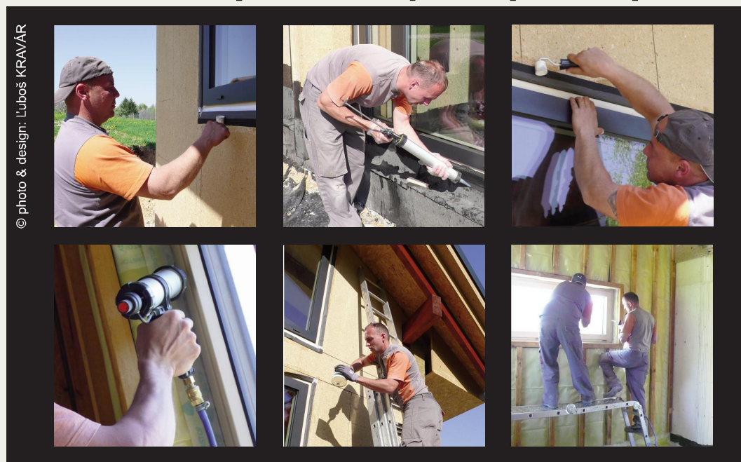
opätovné prelepenie pások a dôkladné utesnenie spojov
